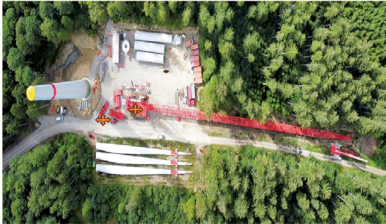
Abbildung 2: Lagerflächen und Fläche für den Aufbau des Kranauslegers zur Anlagenerrichtung © Ingenieurbüro Sing/Lorenz Hartleitner
