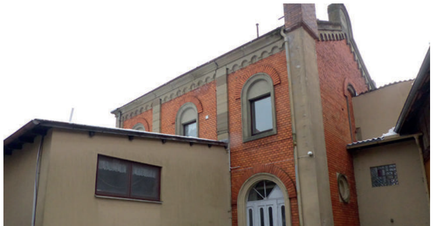
Ehem. Synagoge (Elsweg 8)
