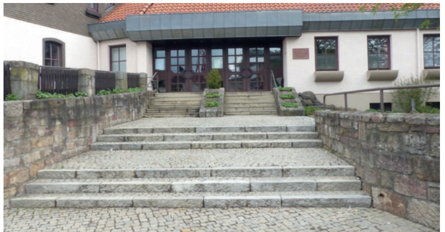
Barrierefreiheit gewährleisten - Bestehender Zugang zur Elstalhalle
