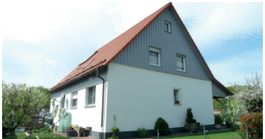
guter Gebäudezustand (Rathgeberstr. 29)
