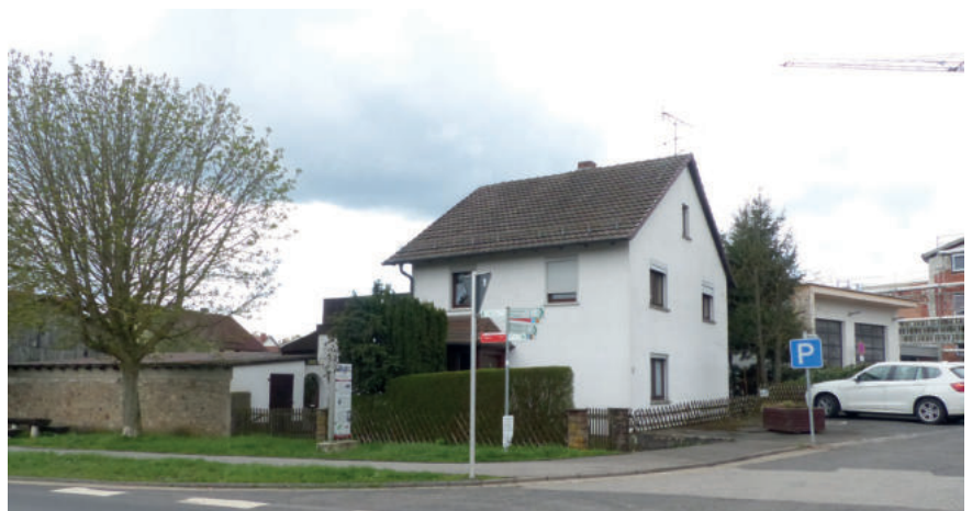
mittlerer Gebäudezustand (Marktplatz 1)
