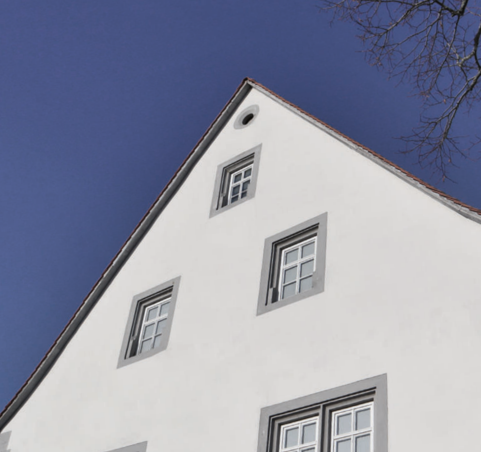
Ortgang mit Zahnleiste und Windbrett
