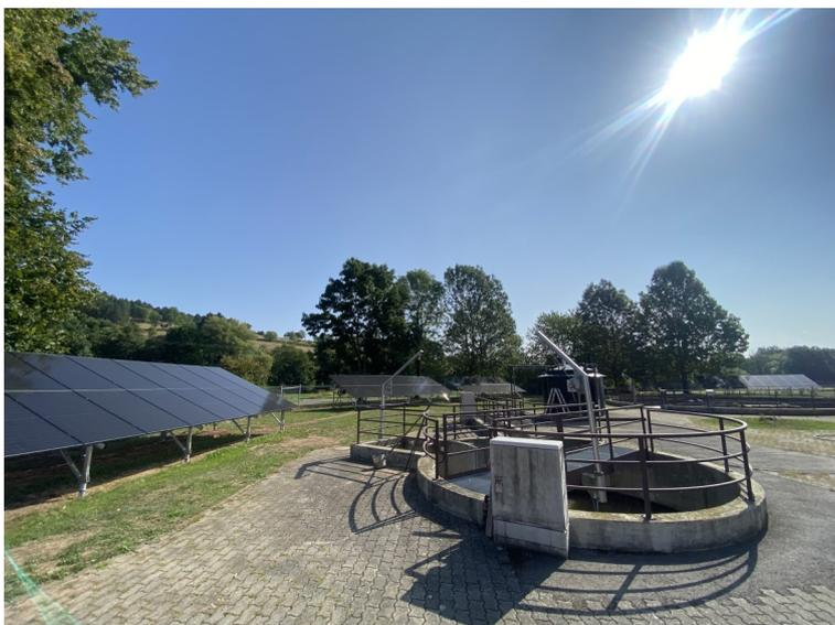
Die neue Freifieldanlage trägt entscheidend dazu bei, den Energieverbrauch der Kläranlage nachhaltiger zu gestalten. An sonnigen Tagen kann die Anlage nahezu autark betrieben werden – ein wichtiger Beitrag, um Betriebskosten zu senken und zugleich aktiv Klimaschutz zu betreiben. Da die Zukunft der Kläranlage – Neubau oder Sanierung – noch nicht endgültig feststeht, entschied man sich bewusst gegen eine Dachanlage und für eine flexible Freifieldlösung.
