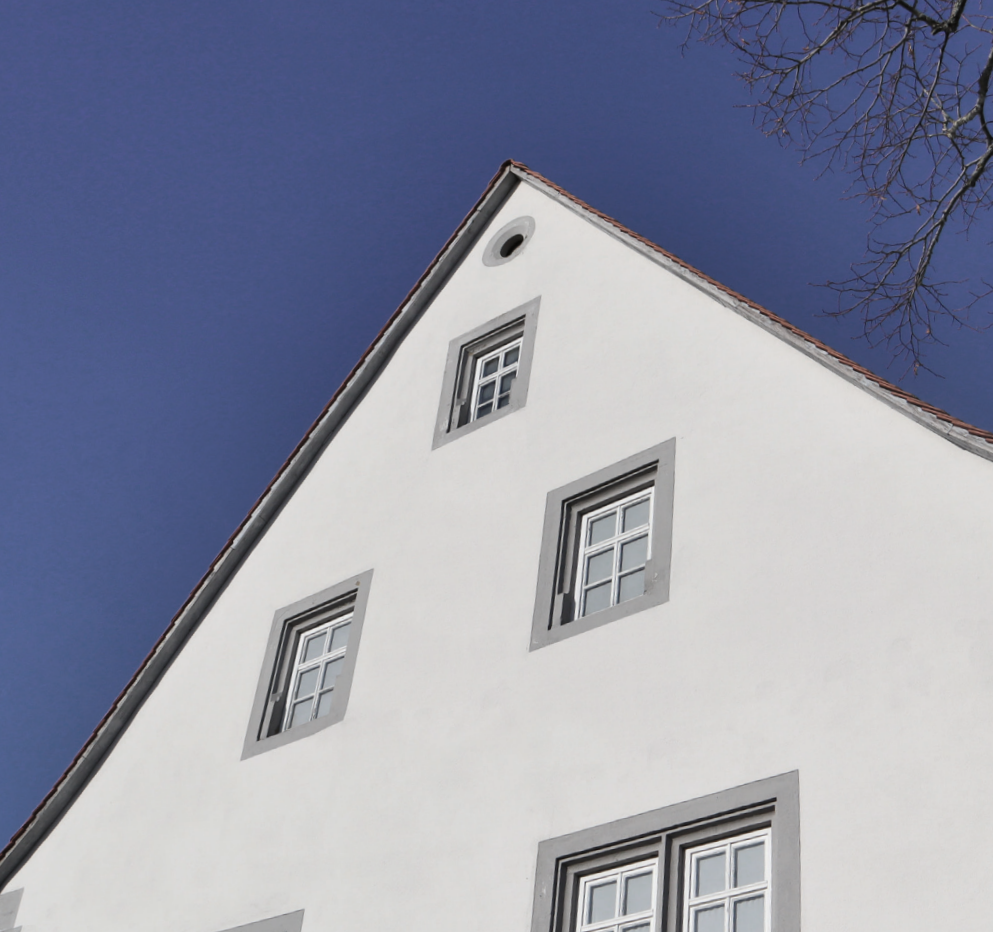
Ortgang mit Zahnleiste und Windbrett
